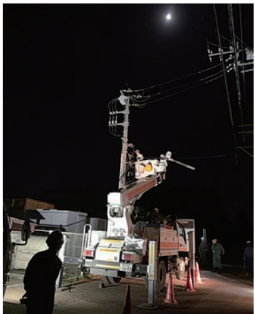
停電6日目の晩、待ちに待った電源車、四国より到着
